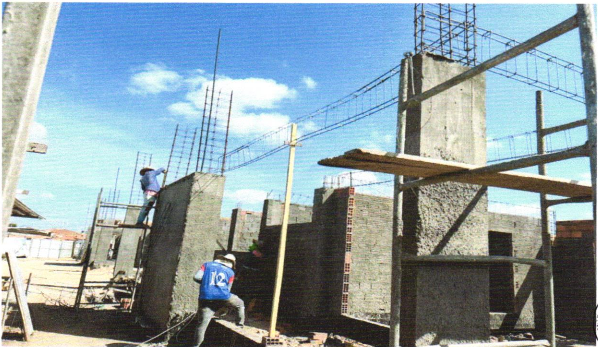
FOTO 36 – Armação de aço CA-50 Ø 10mm; incluso fornecimento, corte, dobra e colocação
