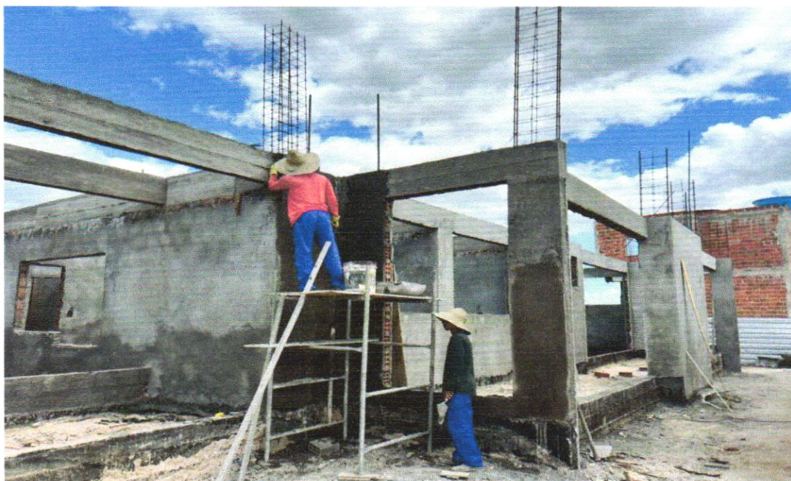
FOTO 62 – Reboco para paredes internas, externas, pórticos, vigas, traço 1:4,5 - espessura 0,5 cm
