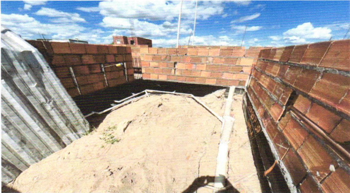
FOTO 70 – TUBO PVC, SERIE NORMAL, ESGOTO PREDIAL, DN 100 MM, FORNECIDO E INSTALADO EM RAMAL DE DESCARGA OU RAMAL DE ESGOTO SANITÁRIO. AF_08/2022
