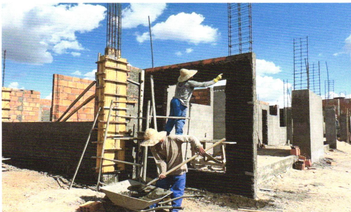
FOTO 60 – Reboco para paredes internas, externas, pórticos, vigas, traço 1:4,5 - espessura 0,5 cm
