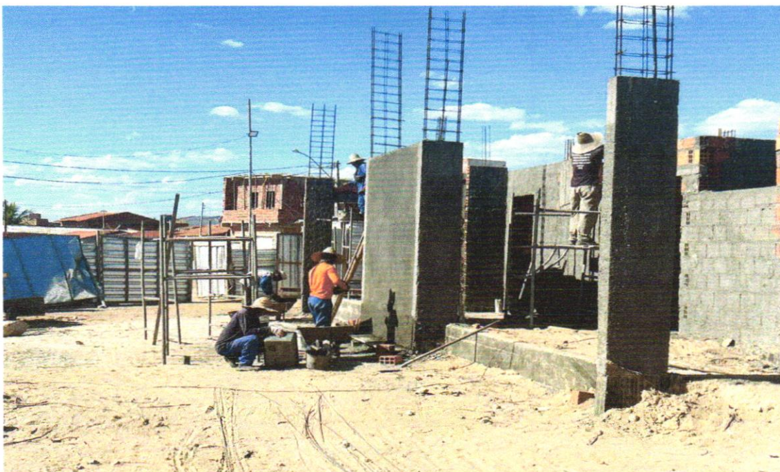
FOTO 62 – Reboco para paredes internas, externas, pórticos, vigas, traço 1:4,5 - espessura 0,5 cm
