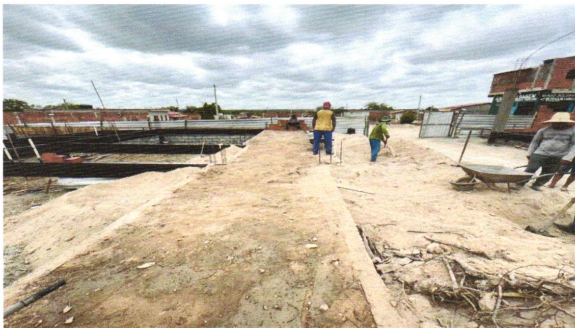
FOTO 02 - ATERRO MANUAL DE VALAS COM SOLO ARGILO-ARENOSO E COMPACTAÇÃO MECANIZADA. AF_05/2016
