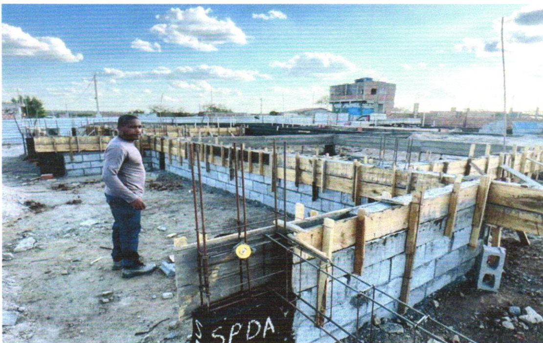
FOTO 18 – FABRICAÇÃO, MONTAGEM E DESMONTAGEM DE FÔRMA PARA VIGA BALDRAME, EM MADEIRA SERRADA, E=25 MM, 4 UTILIZAÇÕES. AF_06/2017
