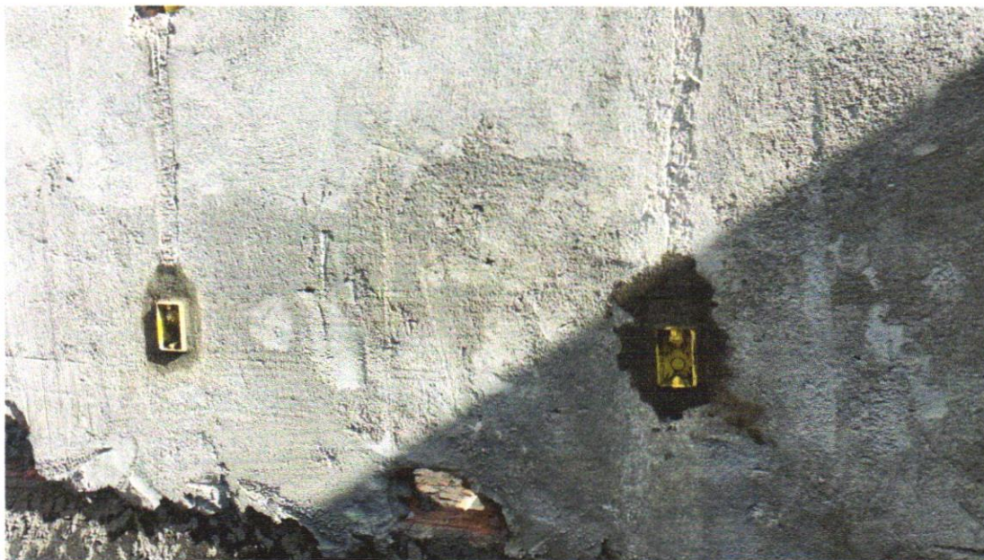
FOTO 78 – Caixa de passagem PVC 4x2"
