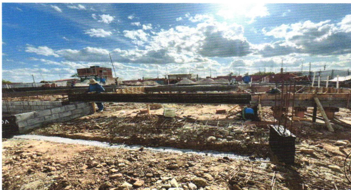
FOTO 10 – LASTRO DE CONCRETO MAGRO, APLICADO EM PISOS, LAJES SOBRE SOLO OU RADIERS, ESPESSURA DE 5 CM. AF_07/2016
