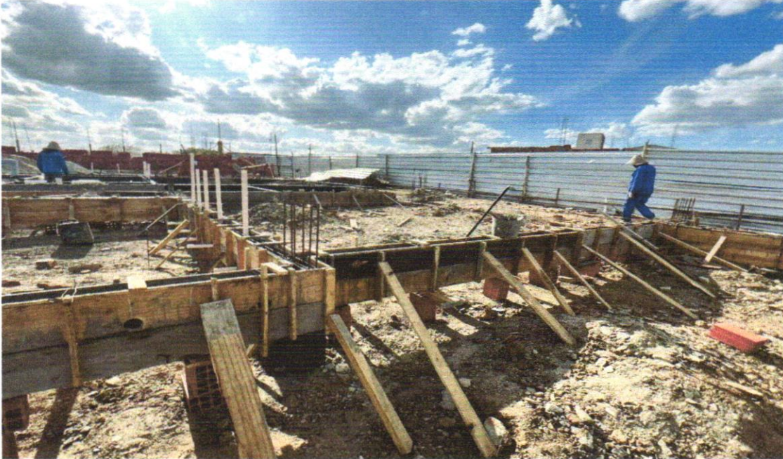
FOTO 18 – FABRICAÇÃO, MONTAGEM E DESMONTAGEM DE FÔRMA PARA VIGA BALDRAME, EM MADEIRA SERRADA, E=25 MM, 4 UTILIZAÇÕES. AF_06/2017
