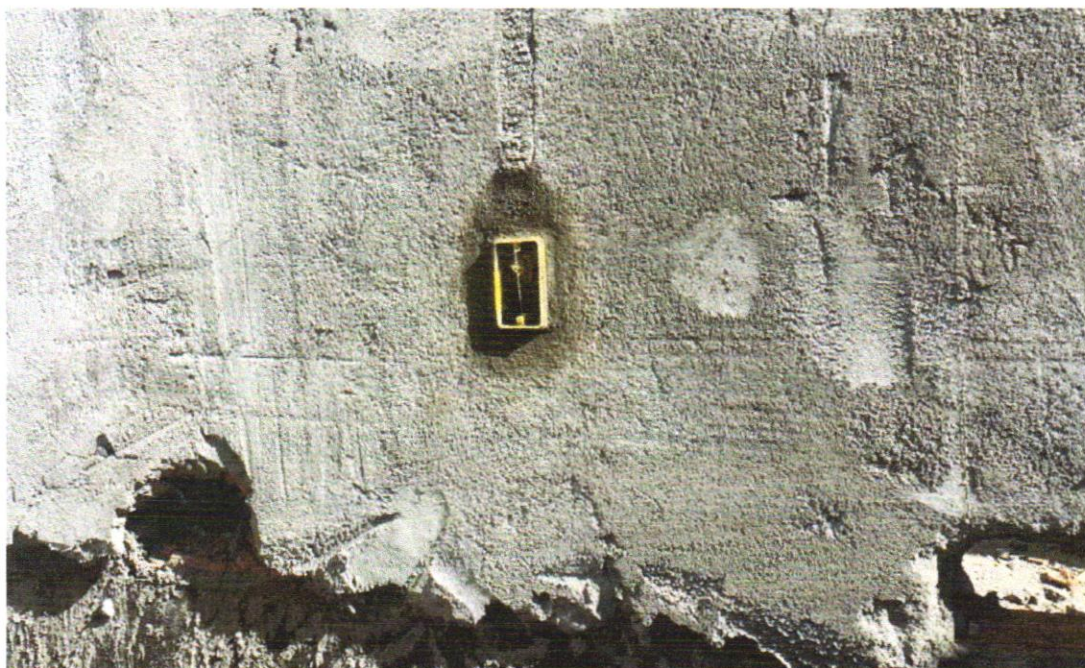
FOTO 76 – Caixa de passagem PVC 4x2"
