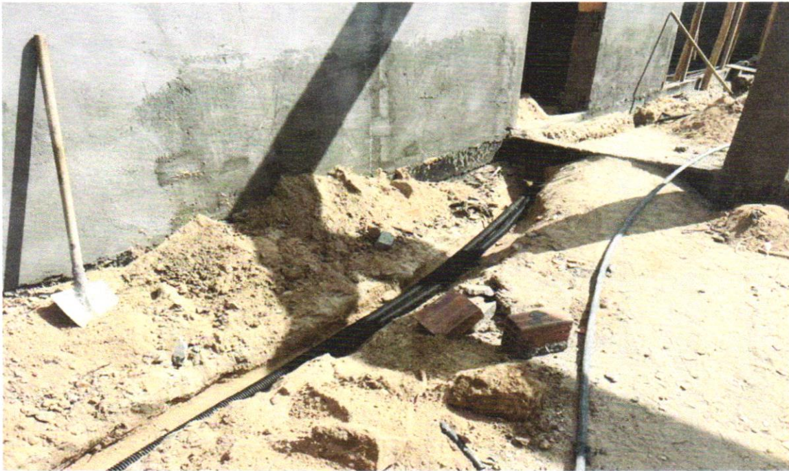
FOTO 84 – Eletroduto PVC flexível corrugado reforçado, Ø32mm (DN 1"), inclusive conexões
