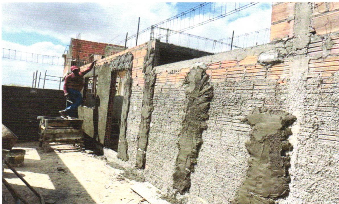
FOTO 60 – Reboco para paredes internas, externas, pórticos, vigas, traço 1:4,5 - espessura 0,5 cm
